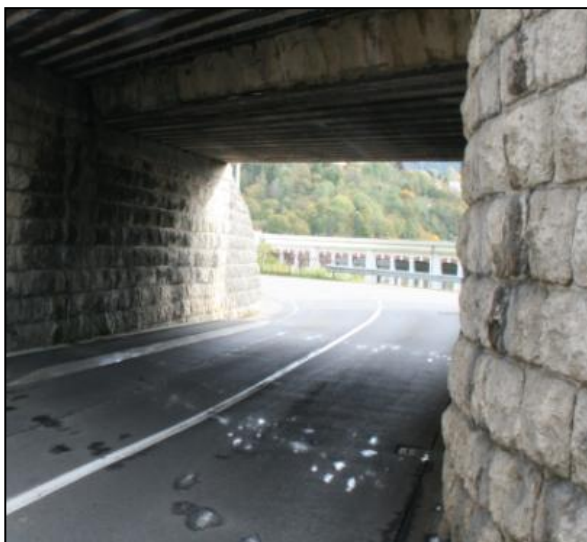
Un trottoir a été intégré dans le sous-voie.
